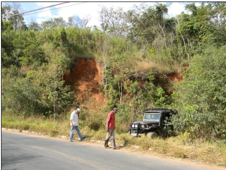
Figura 1: Acesso para nascente CVP-08. Detalhe para pequena erosão laminar ao fundo.
