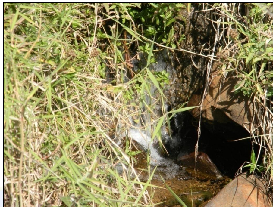
Figura 4: Formação de pequena cascata à jusante do poço, nascente CVP-32.
