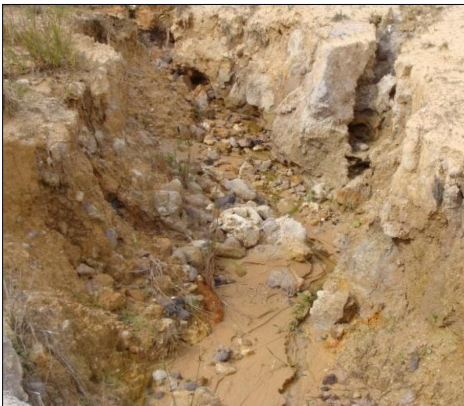
Figura 3: Detalhe da área interior do manancial, onde se pode perceber o grau de degradação da nascente CBR-11.
