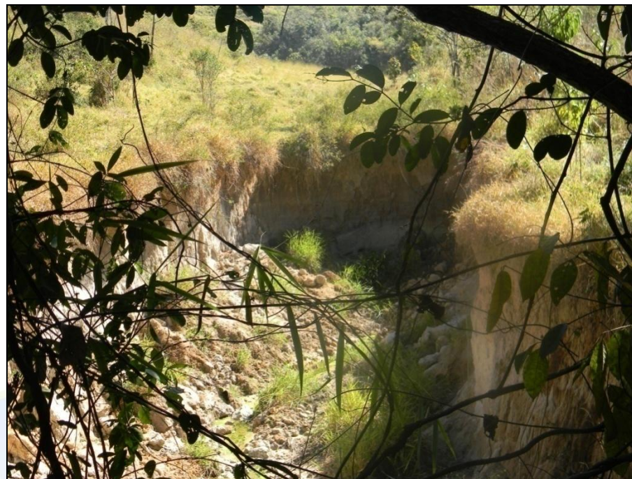
Figura 2: Afloramento do lençol freático dentro de uma voçoroca cuja nascente foi enquadrada como CVP-39.
