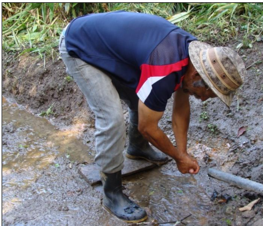
Figura 3: Canalização da nascente CI-04 para fins de uso domésticos, sendo a água captada e drenada por declividade até as áreas residenciais.
