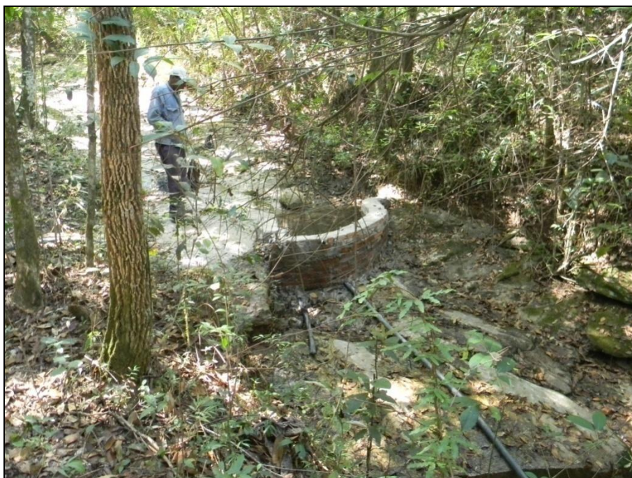
Figura 3: Captação de água da nascente para uso doméstico, por meio de pequeno barramento artificial, ponto CVP-35.
