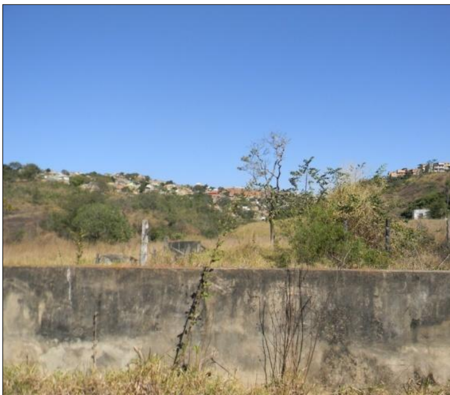
Figura 3: Atividade antrópica na área da nascente CS-06 constatando estar em área urbana.
