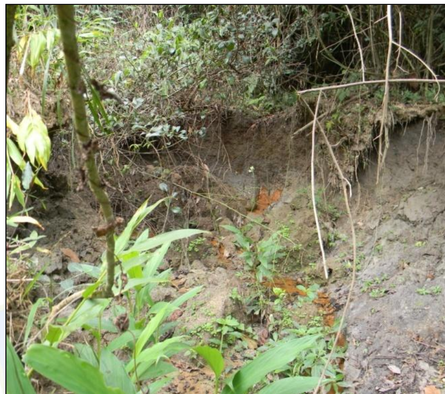
Figura 4: Área de degradação de solo na área da nascente CPI-01.
