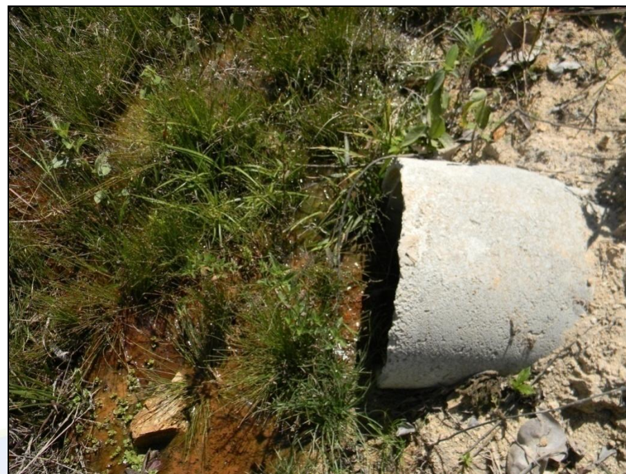
Figura 4: Bueiro para canalização do curso d'água, nascente CVP-24.
