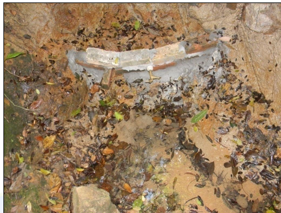
Figura 4: Detalhe para a captação artificial da nascente CVP-04. Água conduzida para ser utilizada para fins domésticos.
