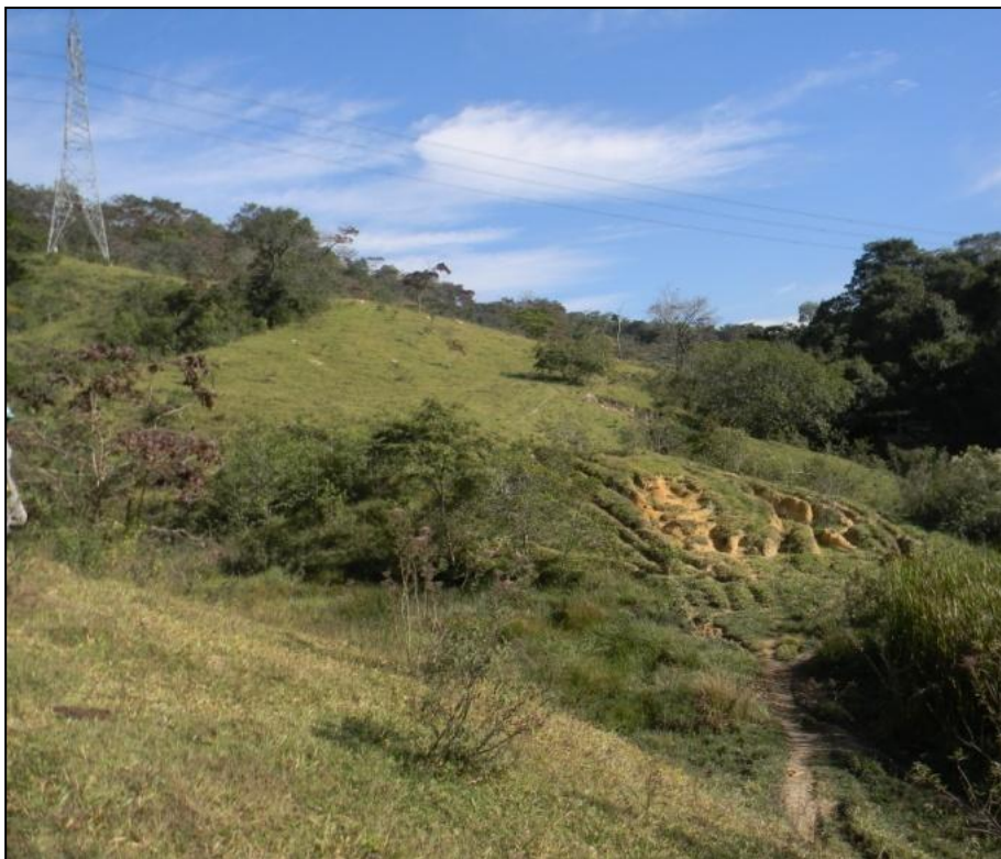
Figura 1: Vista geral da área da nascente CPI-08 onde pode ser observada a presença de linha de transmissão e processo erosivo certamente ligado a construção da mesma.
