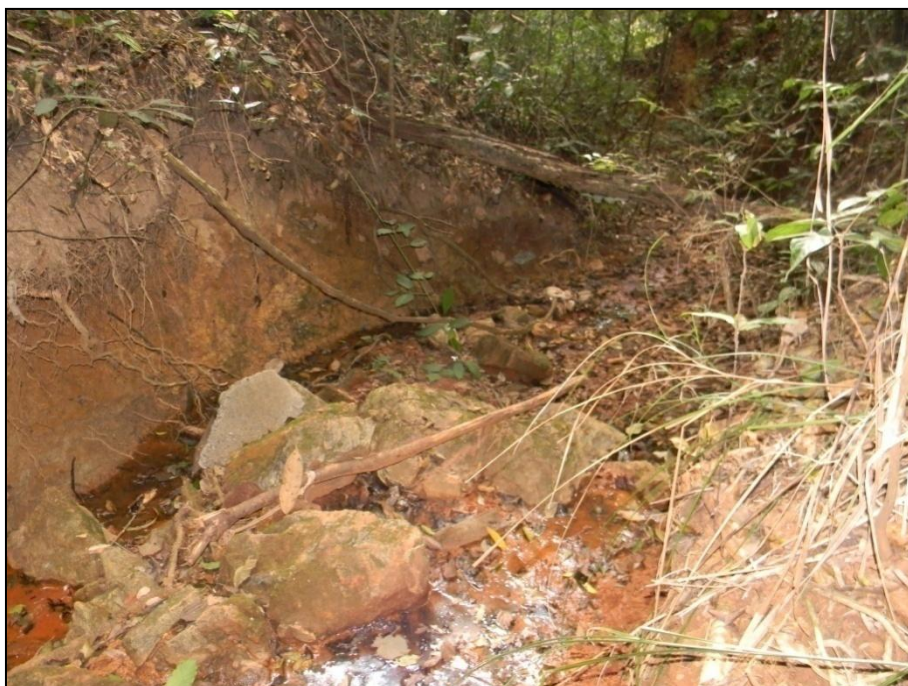
Figura 3: Detalhe do afloramento hídrico em meio rochoso na nascente CVP-21.
