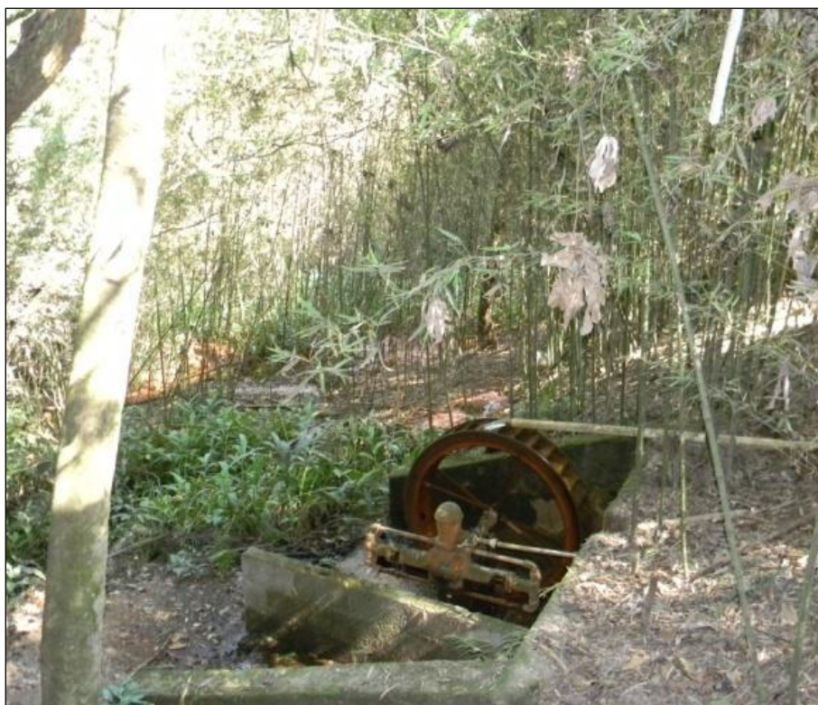
Figura 3: Captação de água na nascente CS-12 sendo feita com a instalação de uma roda de água. Vegetação de bambus predominando como espécie retentora de solos.
