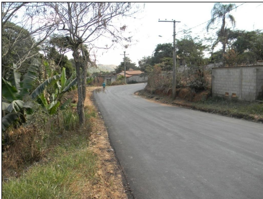
Figura 1: Acesso para nascente CVP-11. Localização em área urbana.
