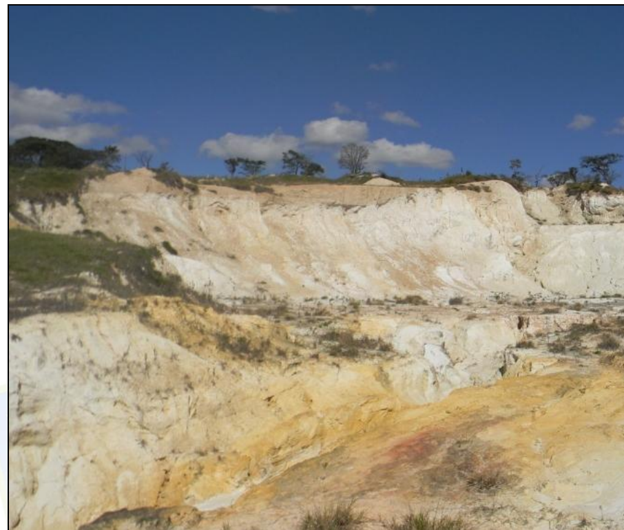
Figura 2: Vista frontal da erosão proveniente da extração de calcita, imediações da nascente CCA-02. Área necessita de manejo adequado para se evitar possíveis impactos negativos ao ecossistema local.
