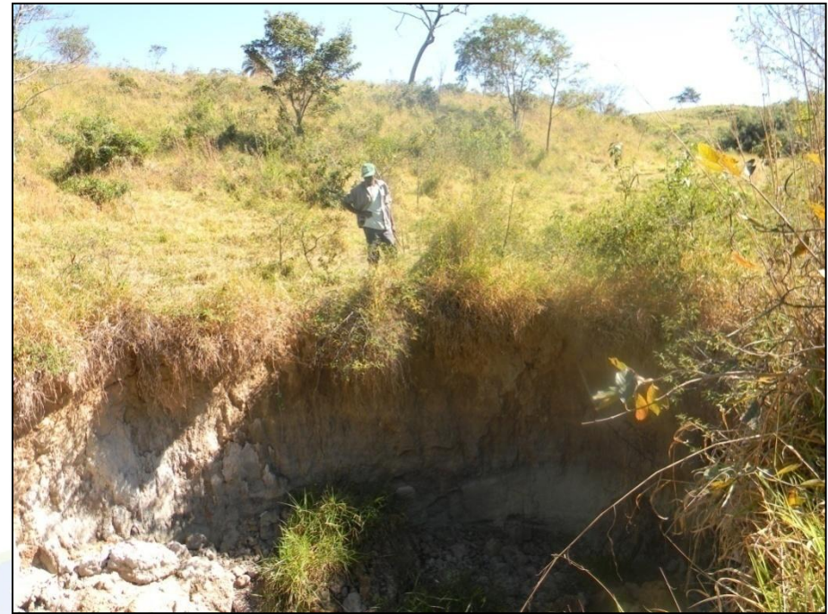
Figura 4: Perfil do solo na lateral da voçoroca, ponto CVP-39.
