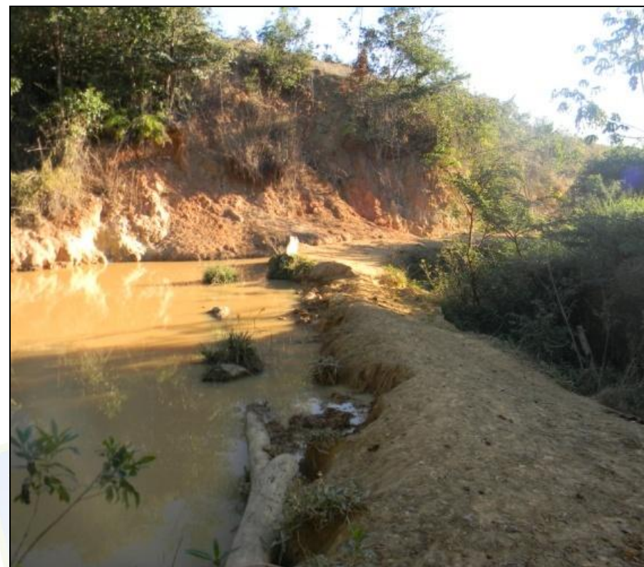
Figura 4: Evidência de área de barranco sem vegetação (erosão superficial na encosta) concorrendo para o assoreamento da nascente CMO-02 e queda de qualidade ambiental da sub-bacia.
