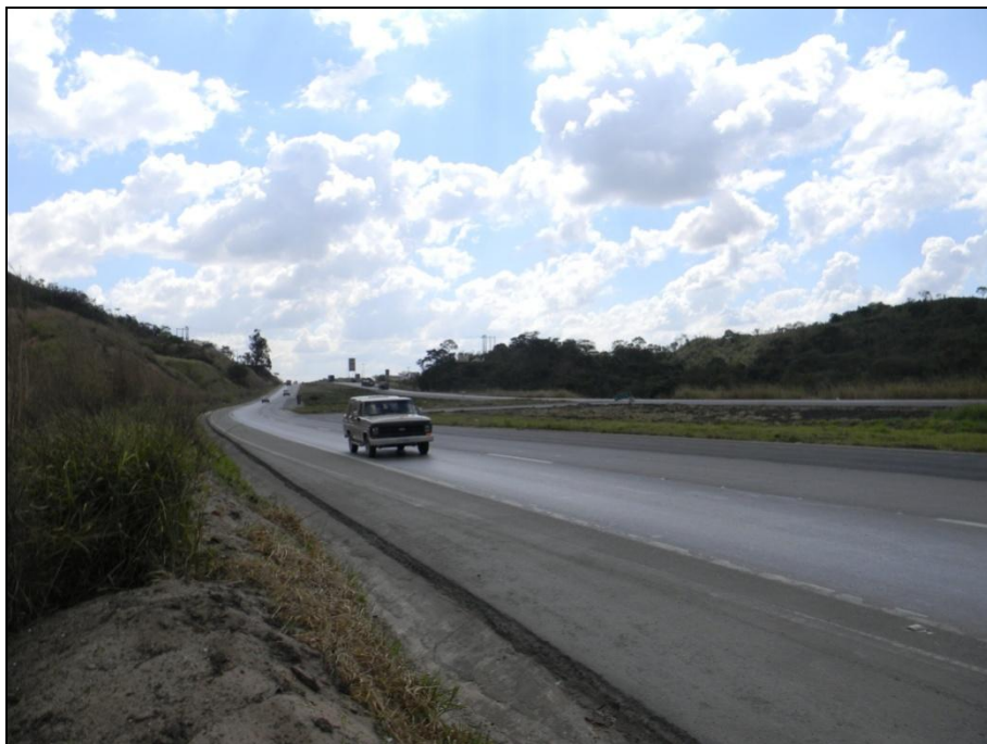
Figura 1: Nascente CVP-09 localizada às margens da rodovia BR-040, sentido Belo Horizonte.
