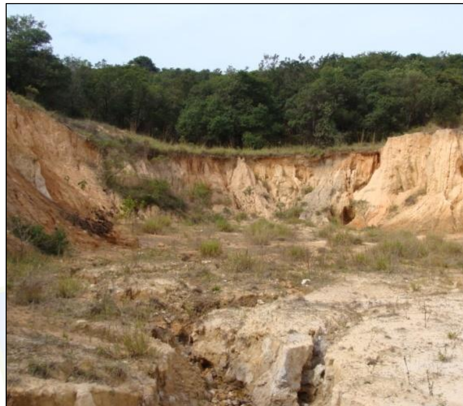
Figura 2: Outra vista da área de nascente CBR-11, tendo em detalhe a mata ao fundo, aparentemente bem preservada, porém na porção central do manancial verifica-se tratar de local bem degradado.
