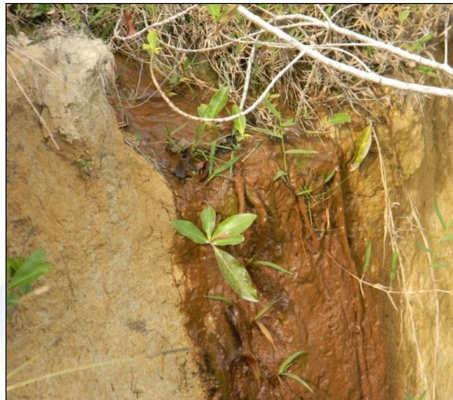
Figura 2: Ponto de surgência da nascente CPI-03 com evidências de transporte de sedimentos.
