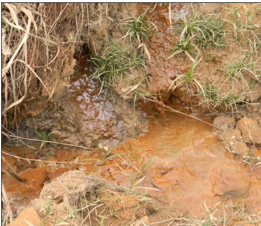
Figura 3: Detalhe do ponto de surgência na nascente CPI-12, verificando ser um solo compactado e degradado por ações de pisoteio de gado em seu entorno.
